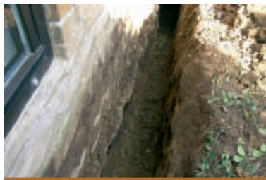
Udgravet rende langs kældervæg
